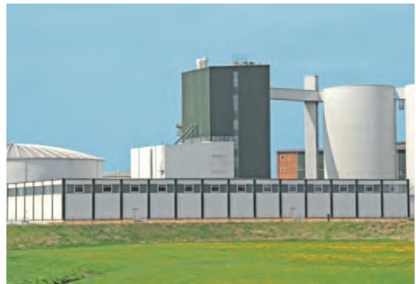
Südzucker AG, Mannheim, ExtruPol Dachabdichtung, 4.000 m 2
