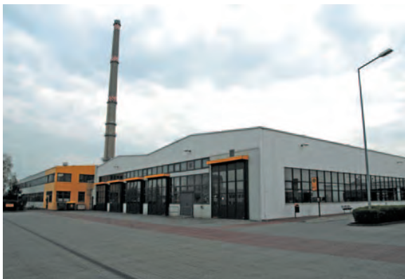
DVB Dresdner Verkehrsbetriebe AG, ExtruBit 10.000m 2 ; ExtruPol Dachabdichtung, 4.000 m 2
