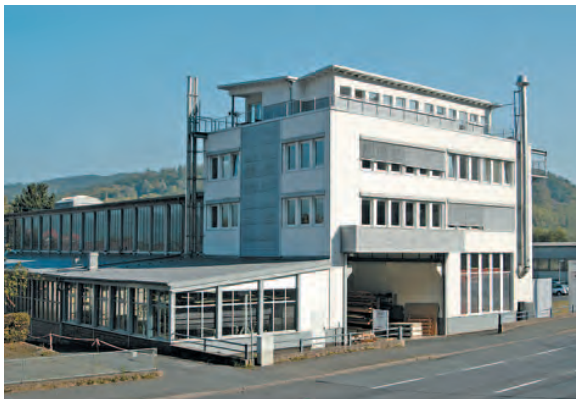
HTT, Hann. Münden, ExtruPol Dachabdichtung, 4.000 m 2
