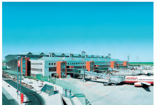
Flughafen Dresden, ExtruPol Dachabdichtung, 6.350 m 2
