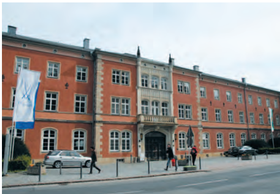
Produktionshalle Porzellanmanufaktur Meissen, Meißen ExtruPol Dachabdichtung, 2.500 m 2
