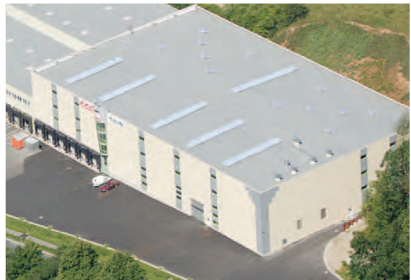
Pufas, Hann. Münden, ExtruPol Dachabdichtung, 7.100 m 2
