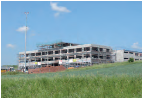
Mobotix AG Firmengebäude, Kaiserslautern ExtruPol Dachabdichtung, 6.000 m 2
