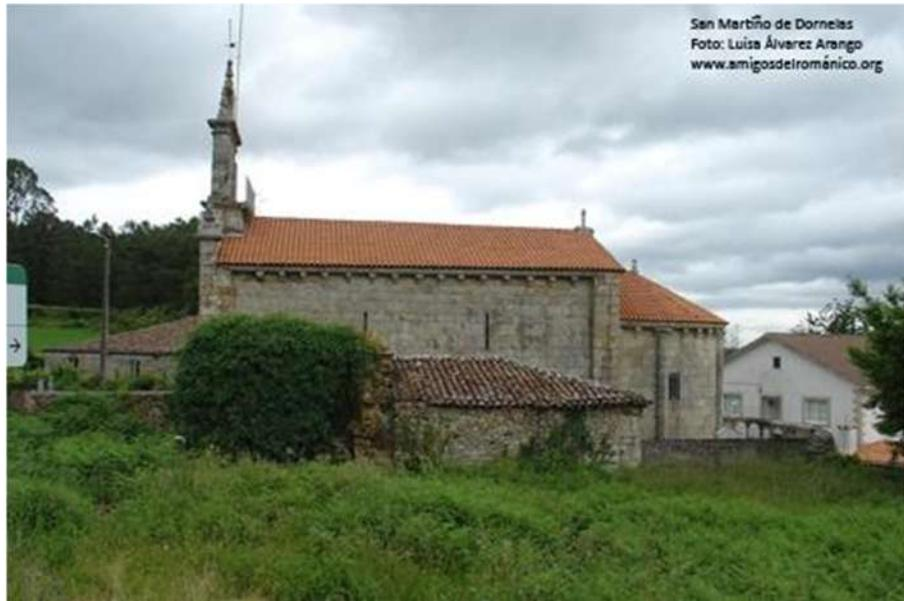
El exterior del ábside consta de cinco tramos separados por columnas que se continúan por fuera del zócalo formado por dos banquetas rematadas en bocel. Tiene alero en chaflán con pequeñas flores de varios botones y canecillos de arista. Los capiteles son en general vegetales. La ventana del tramo central es completa y sigue el modelo de las puertas.
