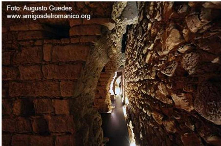
En la antigua arquitectura romana, un **criptopórtico** es una galería abovedada subterránea o semisubterránea, creada con objeto de resolver la pendiente del terreno. El criptopórtico de Coímbra, de dos plantas, fue construido para soportar el foro de la ciudad.
