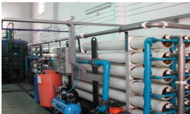
Fig. 3 Una de las tres desaladoras de agua de mar de El Hierro. Fuente: Consejo Insular de Aguas de El Hierro.
