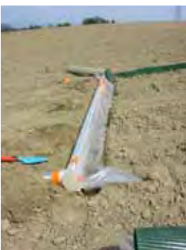
3° étape Pose de la gouttière aval et de la bâche
