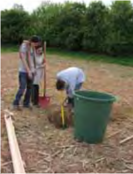
1° étape Implantation des cuves à ruissellement (Mai 2004)
