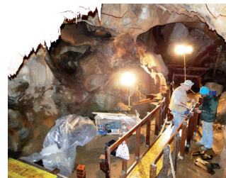
Fig. 17 - Aspeto das obras de montagem da nova estrutura de visita
