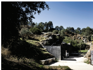
Fig. 20 - Exterior da gruta requalificada
