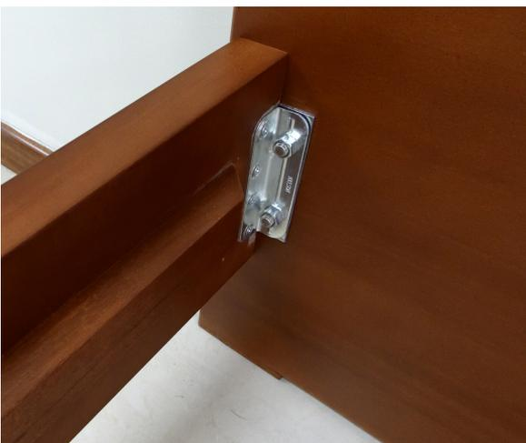
Para el ensamblaje de los largueros, utilizamos tarugos de madera y 4 placas metálicas de alta resistencia.
