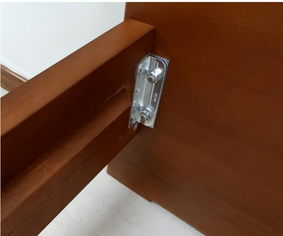
Para el ensamblaje de los largueros, utilizamos tarugos de madera y 4 placas metálicas de alta resistencia.
