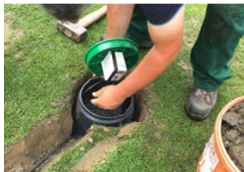
Подготовка оросительного бокса для регистратора данных
