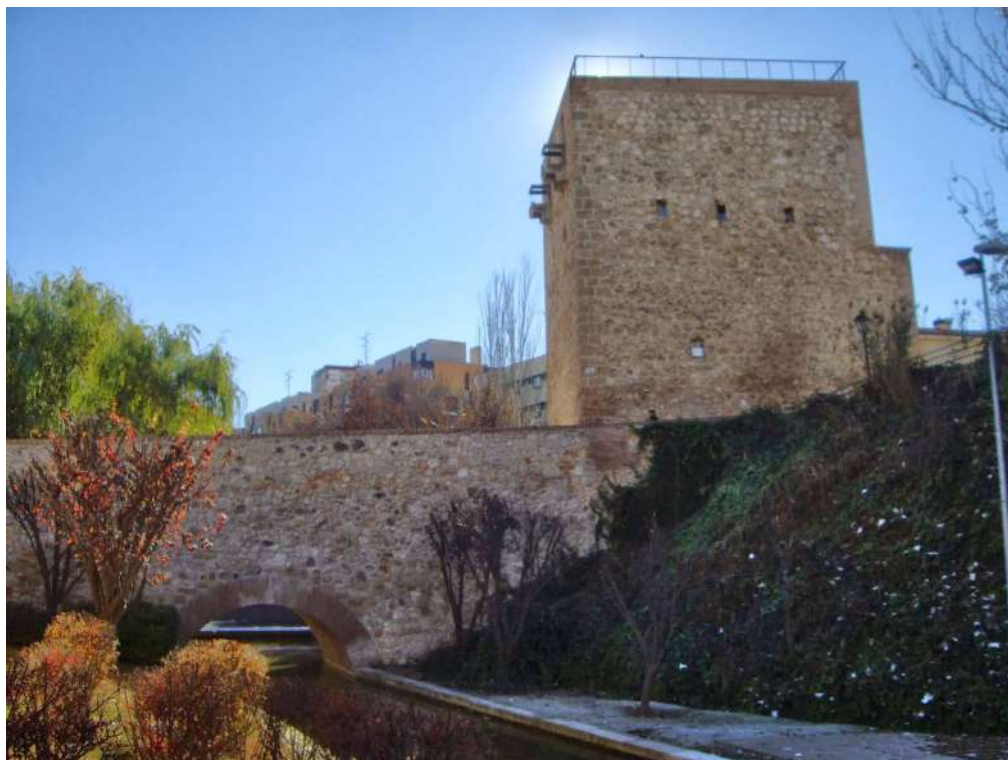
Torreón del Alamín y puente de las Infantas
