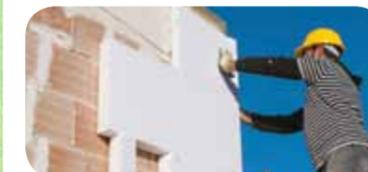
Pour lutter contre les ponts thermiques, l'isolation par l'extérieur des murs et de la toiture est une technique très efficace.
