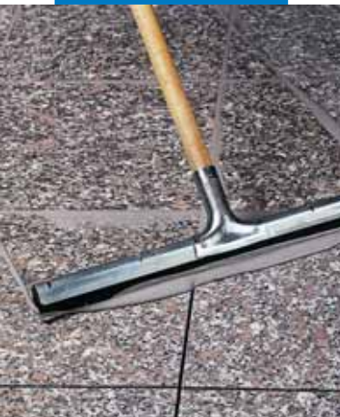
Шпаклевка полового покрытия из полированного гранита скребком
