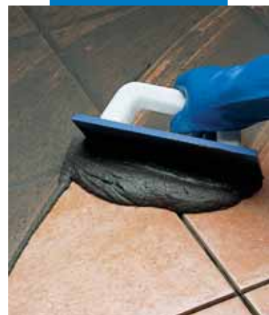
Шпаклевка плитки одинарного обжига шпатлем
