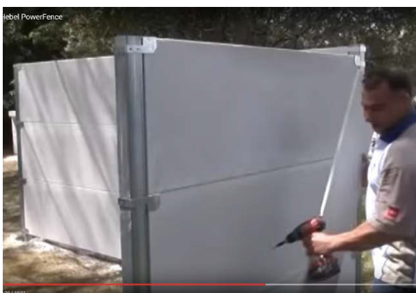
6. Pemasangan Panel AAC lapis terakhir
