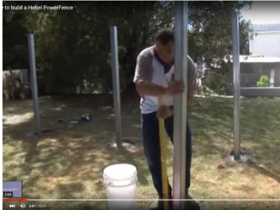
1. Pemasangan kolom hollow
