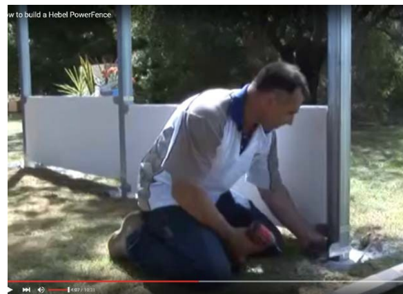
4. Pemasangan bracket sudut
