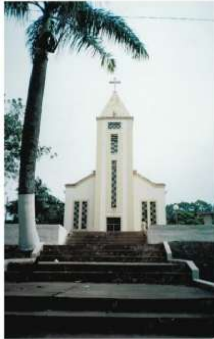
Capela da comunidade rural de Buritis, em frente a provável sede da Fazenda Buritis, que era propriedade de Manoel Pereira.
