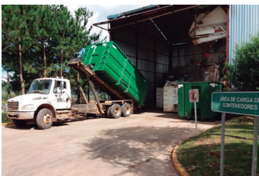
Estación de transferencia intermunicipal Simar Sureste.
