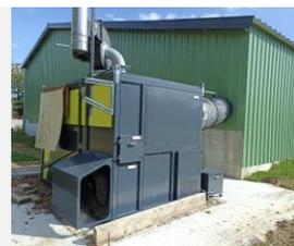
■ **Batterie d'eau chaude en provenance d'une chaudière ou d'une unité de méthanisation en co-génération** : Placée devant l'ouïe du ventilateur, l'échangeur air/eau permet de réchauffer l'air en provenance du capteur solaire ou de l'extérieur du séchoir. L'eau chaude circulant dans l'échangeur peut provenir d'une chaudière ou du système de refroidissement du moteur d'une unité de méthanisation en co-génération.
