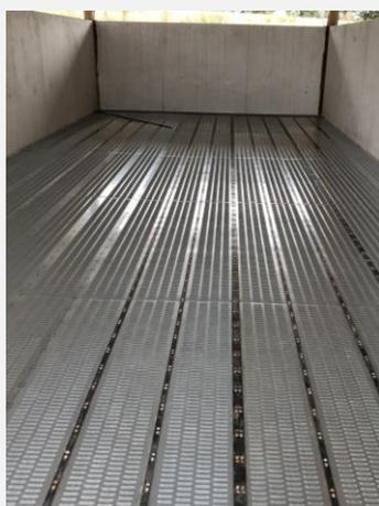
Ce type d'installation est un système hybride entre les deux présentées ci-dessus. Il se compose de poutres lamellées-collées isolées d'une dalle bétonnée par une ou deux épaisseurs d'OSB. Le tout est recouvert de tôles métalliques à fentes. Les poutres disposées dans le sens de la longueur créent ainsi des caniveaux qu'il est possible d'ouvrir ou fermer selon les besoins.
