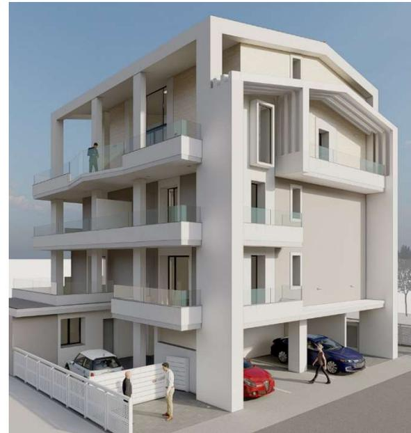
Con il sistema Xlam è possibile costruire strutture multipiano completamente a secco, riducendo tempi, agenti inquinanti, preservando le caratteristiche termiche ed sismiche del legno. La finitura esterna è personalizzabile, con intonaci colorati, rivestimenti, pareti ventilate. Le costruzioni in Xlam si prestano bene anche per soluzioni che presentano ampi aggetti.
